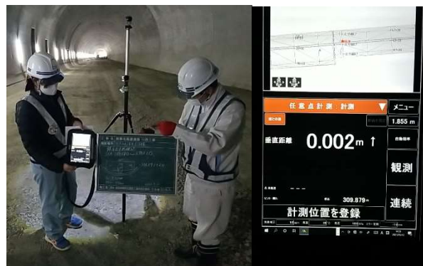
写真-2 出来形検査状況
