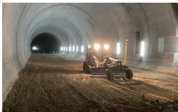
写真-4 施工状況 (MC 搭載グレーダ)
