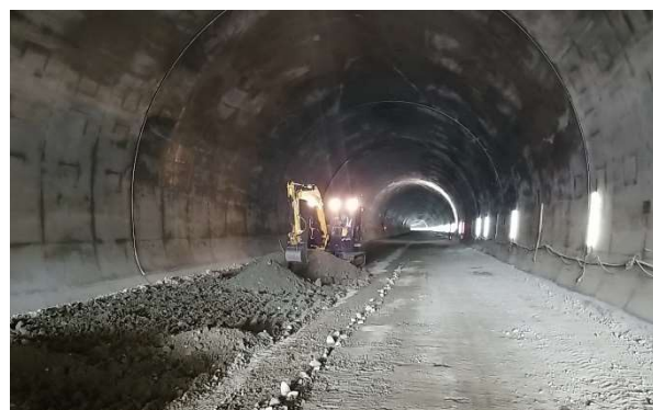
写真-3 施工状況 (MG 搭載バックホウ)
