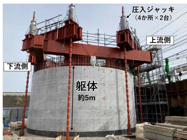
(a) ケーソン基礎外観
