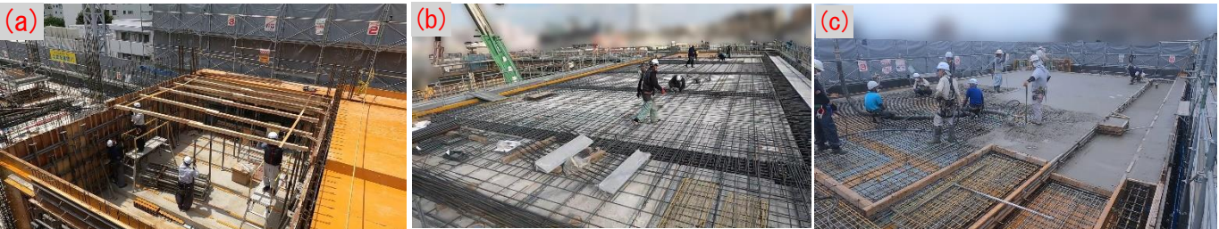
(a) 型枠組立 (A) (b) 鉄筋組立 (B) (c) コンクリート打設 (C)
