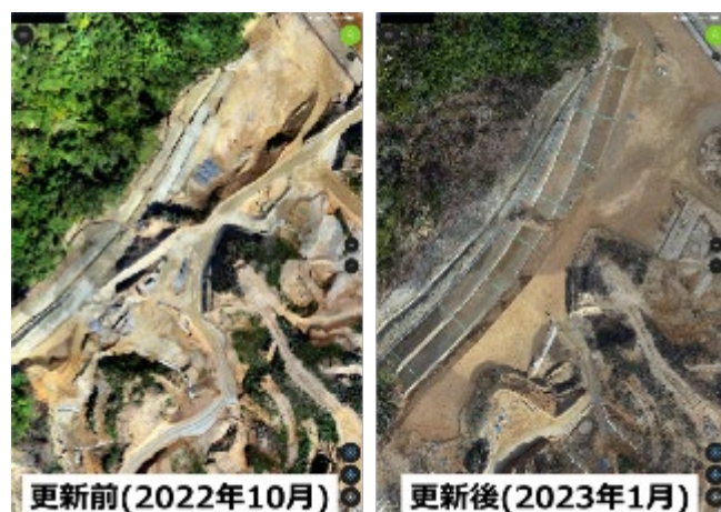
図-3 更新前後のオルソ画像による工事進捗
