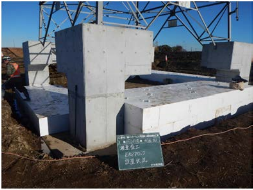
写真-1 防護工写真
