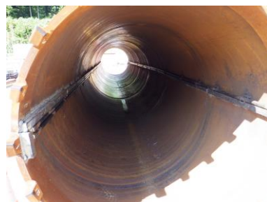
写真1 鋼管杭内エアブロー管設置状況
