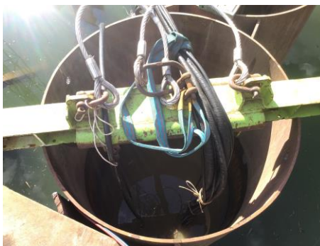
写真5 鋼管杭切断状況
