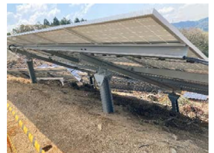
写真-6 完成状況（近景）
