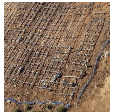
写真-4 施工時防護ネット設置状況
