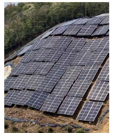
写真-5 完成状況（遠景）
