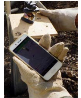
写真-3 杭ナビ測定状況
