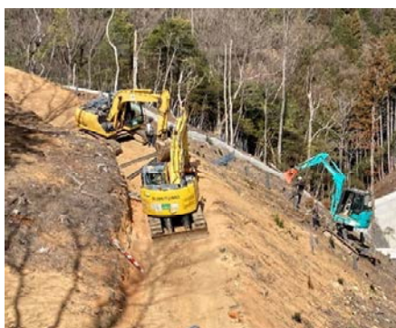
写真-1 傾斜地杭施工状況（上方より）
