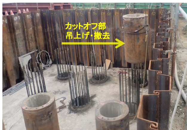
写真-2 カットオフ状況
