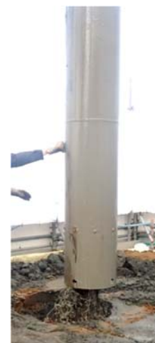
写真-5 スライム除去用ケーシングバケット 吊り上げ・泥水排出状況
