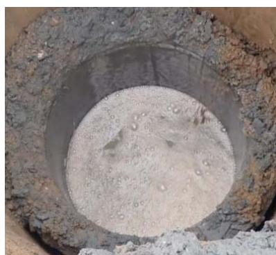
写真-3 スライム除去前 （杭打ち込み完了後）
