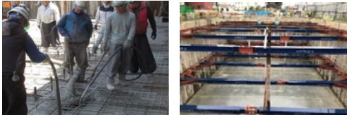
写真-1 打込み状況と打込み完了
