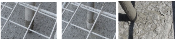
写真-2 バイブレータ挿入状況
