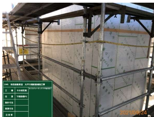
写真-1 気泡緩衝シートによる養生
