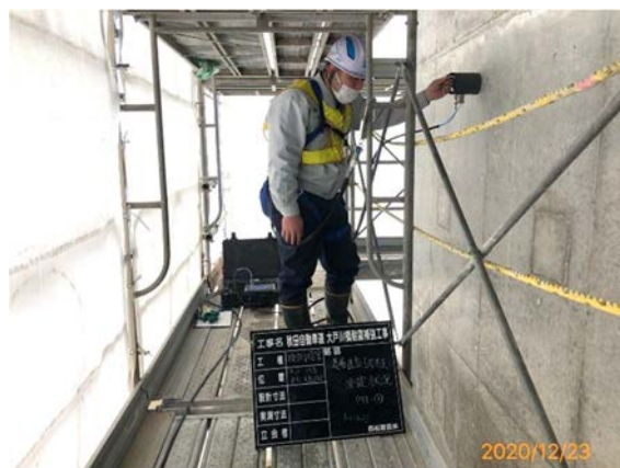
写真－4 トレント試験状況
