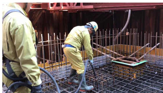
写真-2 ホロレンズ装着による締固め作業状況
