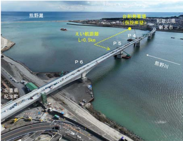
写真-1 橋梁全景
