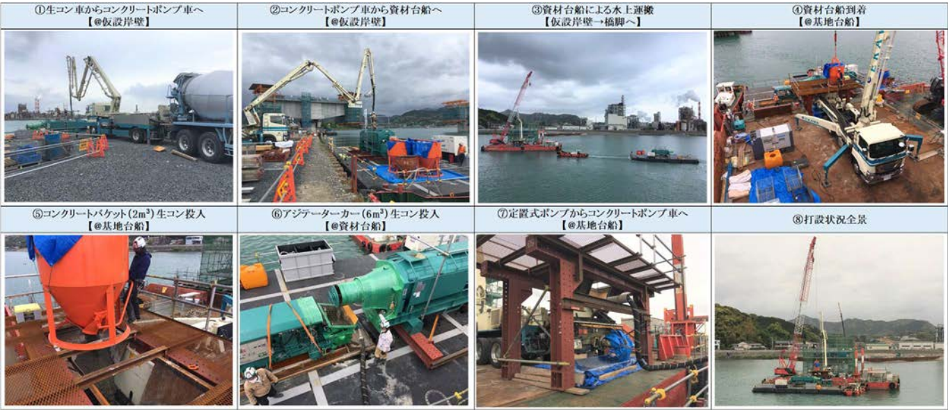
写真-2 打設状況
