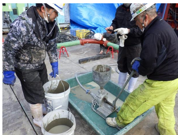
写真-2 セメントミルク圧入状況
