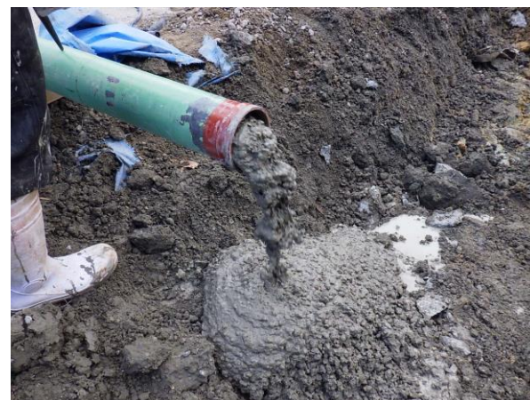
写真-3 コンクリート再圧送後の吐出状況
