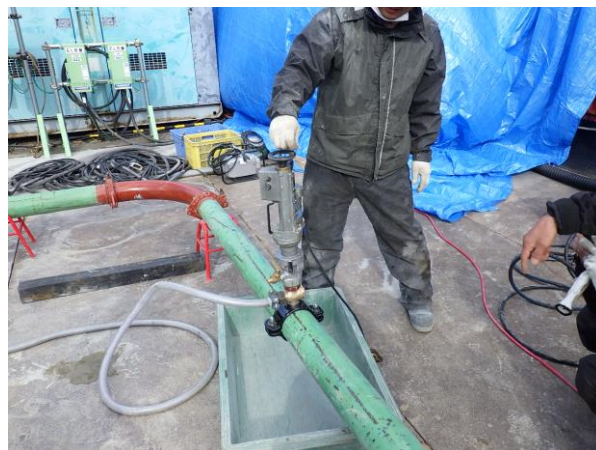
写真-1 削孔状況
