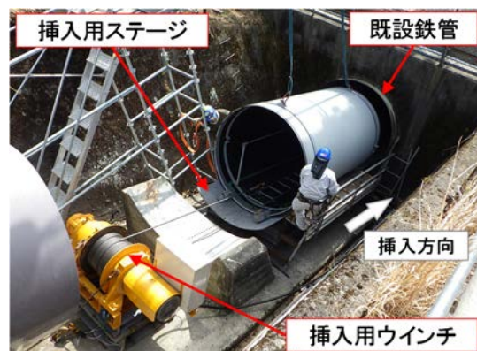
写真-4 鉄管挿入状況 (最上流箇所)
