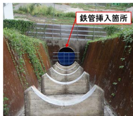
写真-1 鉄管挿入箇所(着工前)
