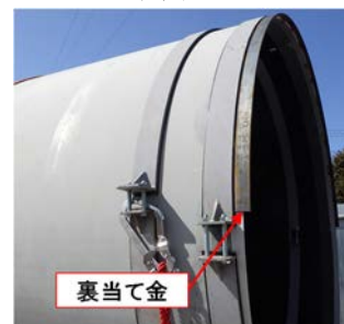
写真-2 裏当て金設置状況
