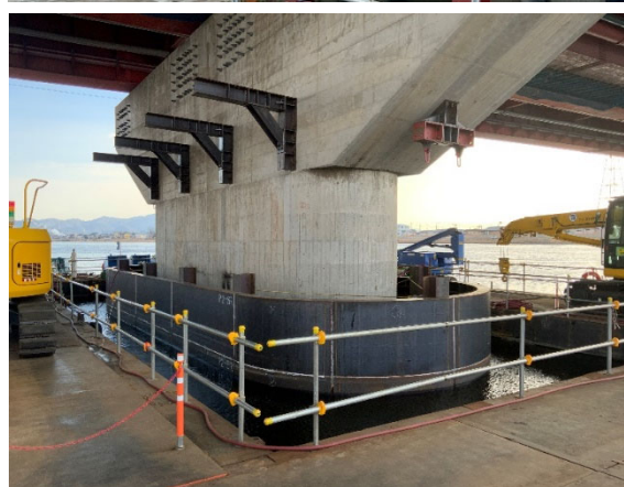
写真-2 仮締切圧入・設置完了状況
