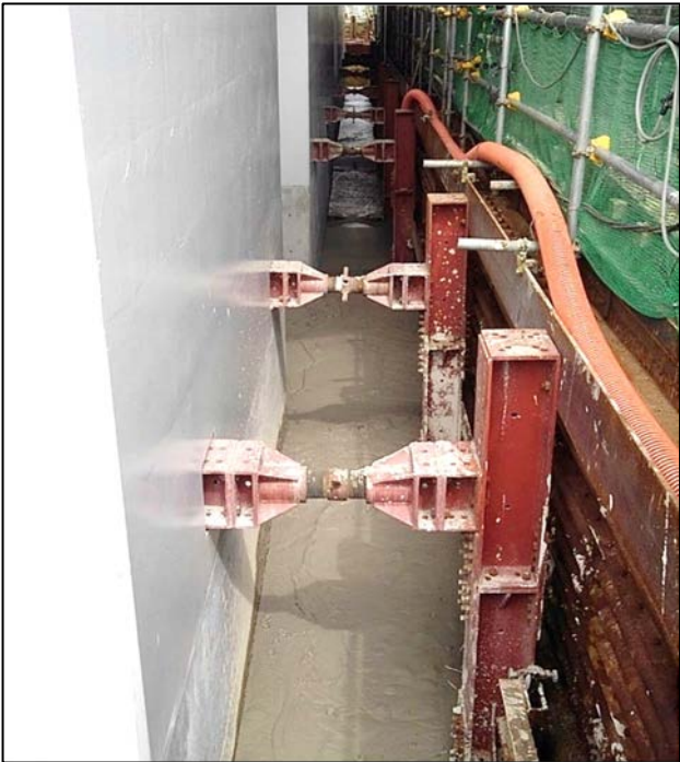
写真-2 流動化処理土打設完了時
