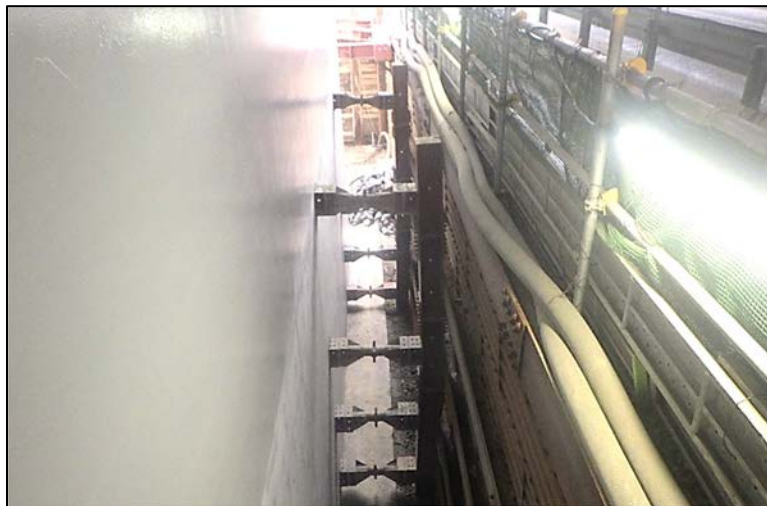
写真-1 埋戻し前の土留め設置状況
