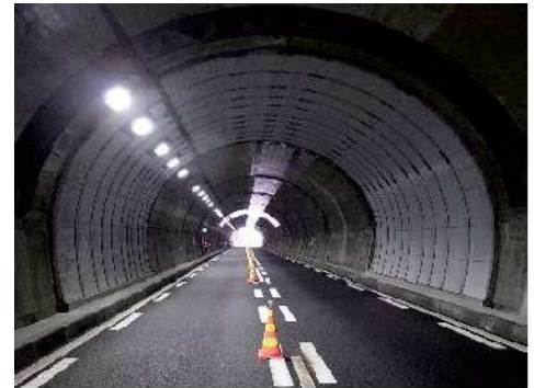
図-1 本工法の施工事例
