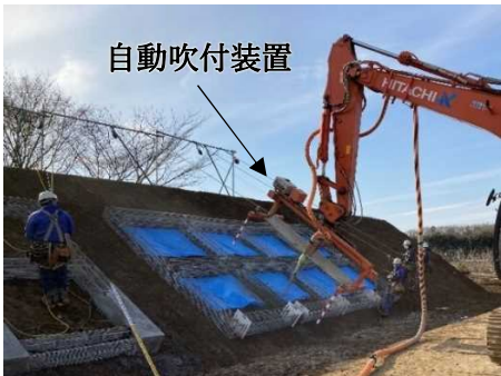
写真 1 自動吹付装置
