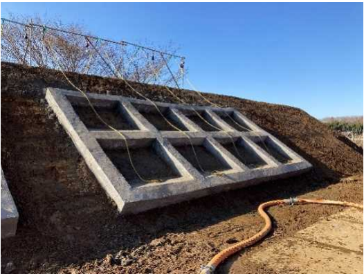
写真2 のり枠完成状況
