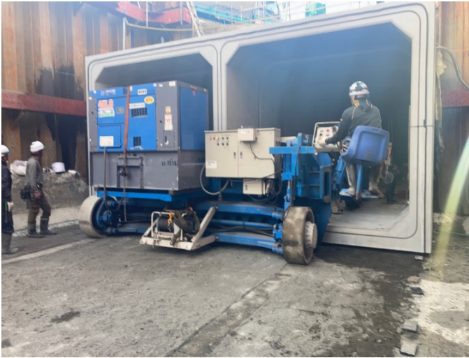
写真－2 リフトローラーによる施工状況
