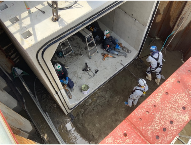
写真－3 人力による据付状況
