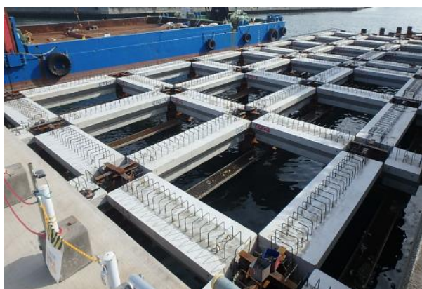
写真-1 PCa 梁据付完了
