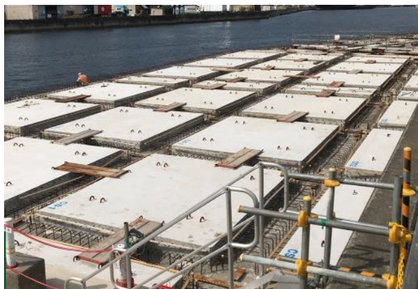
写真-2 PCa 床版据付完了
