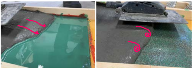
写真-4 UHPFRC 打ち込み状況
