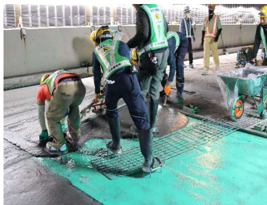
写真-1 人力施工状況
