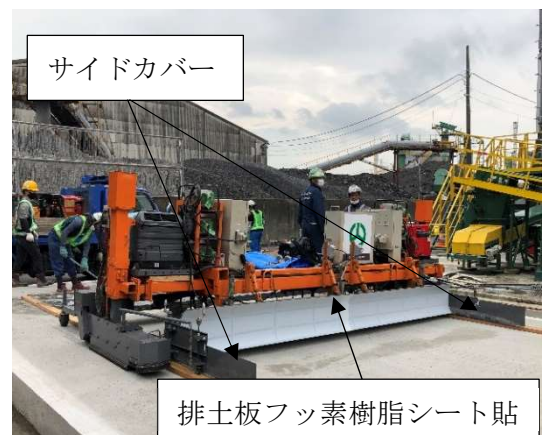
写真-3 超速硬型 UHPFRC 専用 自走式コンクリートフィニッシャー
