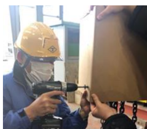
図10 防音装置の取付状況
