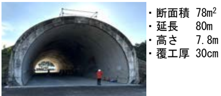
模擬トンネル全景 (正面)
