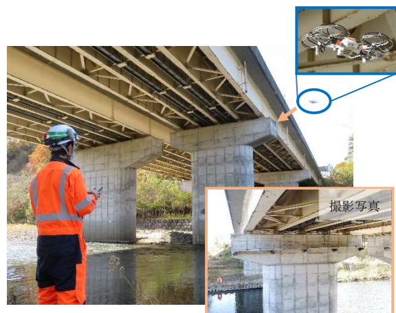
写真-2 ドローン調査状況
