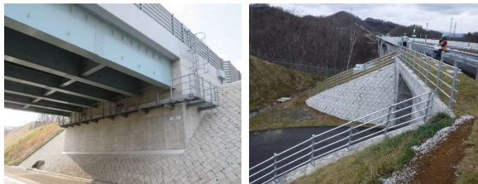
写真-1 検査路及び転落防止柵
