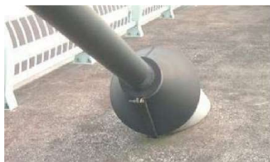
写真 2 ケーブル定着部 3)
