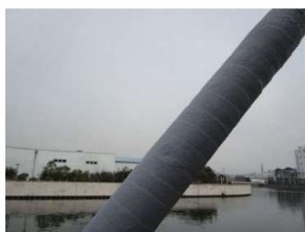
写真4 専用テープによる対策事例 3)
