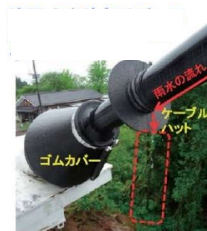
写真5 止水ゴムカバーの取替 3)
