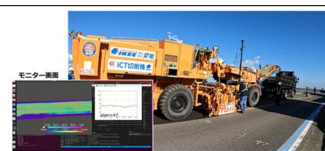
図2 オペレーターへのモニター表示は施工中に直観での判断ができない課題が抽出
