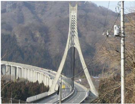
写真 1 碓氷橋（斜張橋部）
