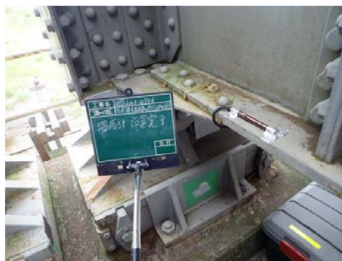
写真-5 温度計設置状況
