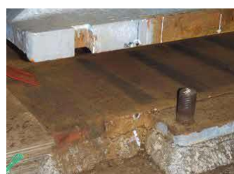
写真-4 床版の状況
