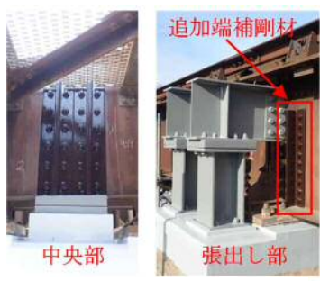
図6 施工完了状況
