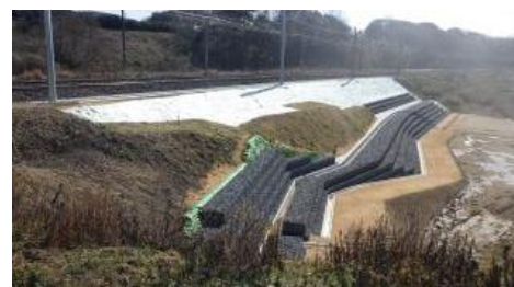
図-5 復旧工事完了後の状況
