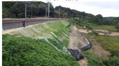
図-4 応急工事完了後の状況
