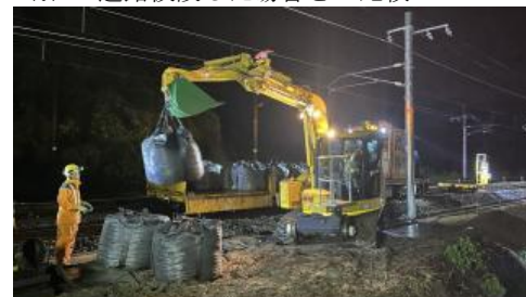
図-7 軌道用 MC による資材搬入
