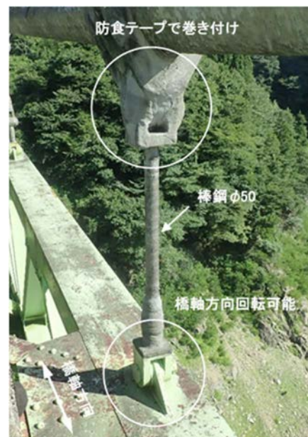
写真-2 ハンガー定着部回転性能
