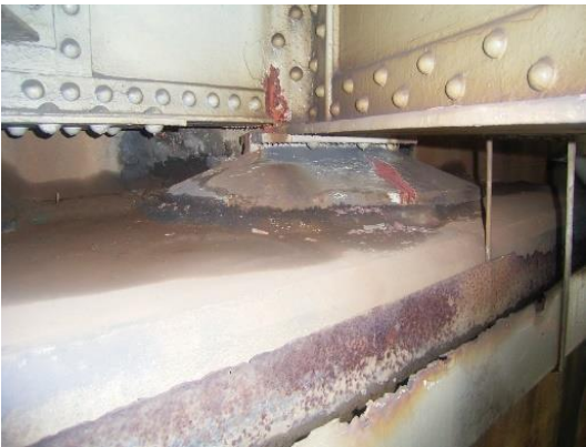
写真-2 支承部周辺の状況
