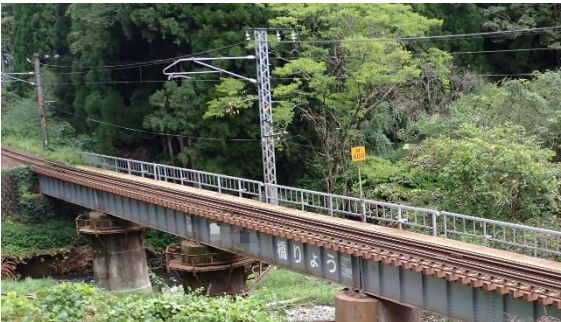
写真-1 対象橋りょう全景
