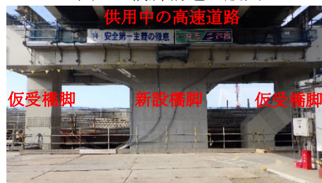
写真-1 造り替え後のP7新設橋脚
