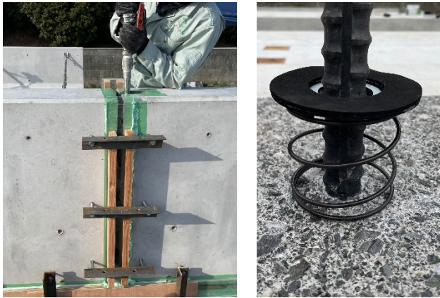
写真-2 モルタル充填状況と逆流防止弁
