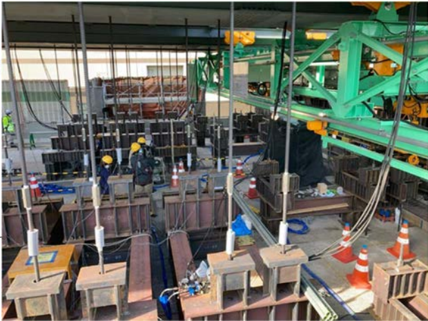
写真-1 アンバランス部施工状況
