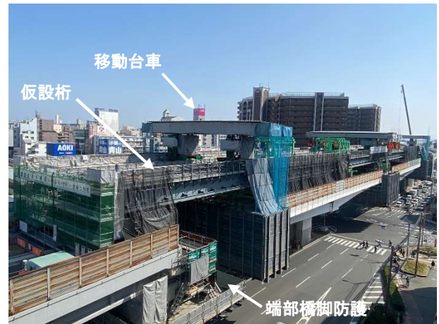
写真-1 施工状況
