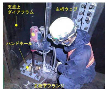
図-4 アンカーの施工状況
