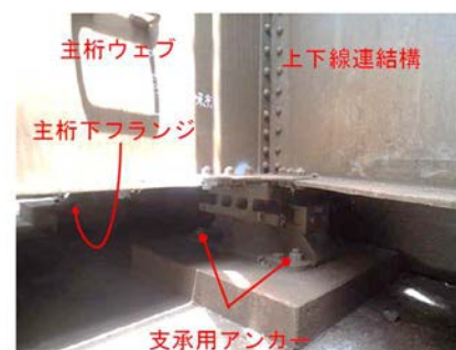
図-3 中間支点上の既設支承
