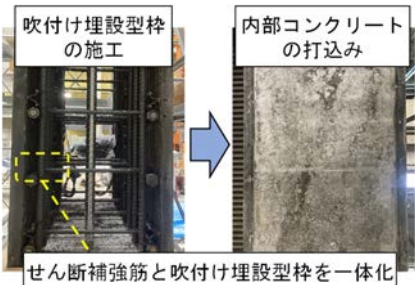
写真-1 吹付け埋設型枠の施工
