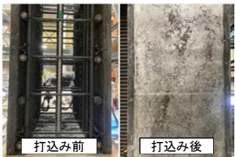
写真-2 打込み前後の状況
