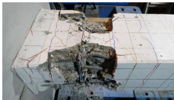
写真-2 タイプ2の主鉄筋
