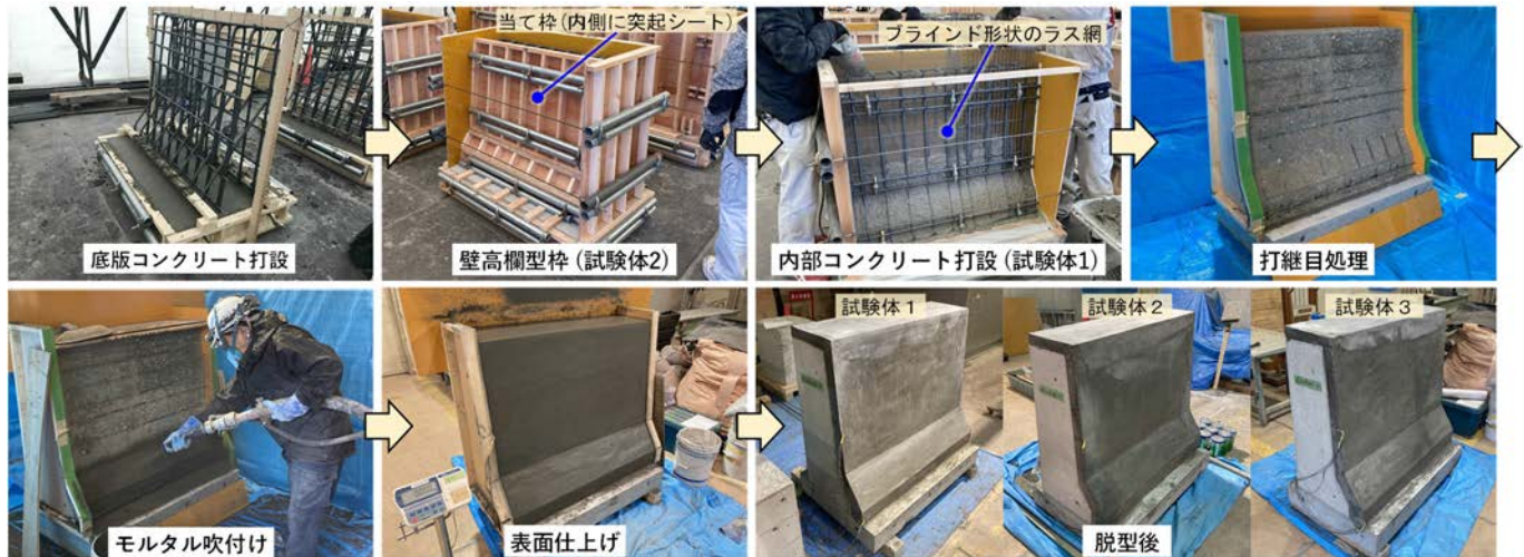
写真-1 施工実験の状況
