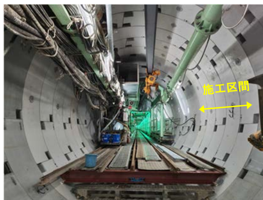
写真-4 施工後の坑内状況
