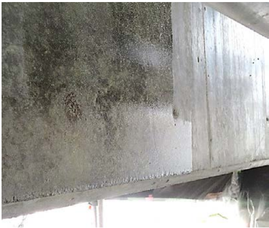
図-4 2 層目施工中のコンクリート
