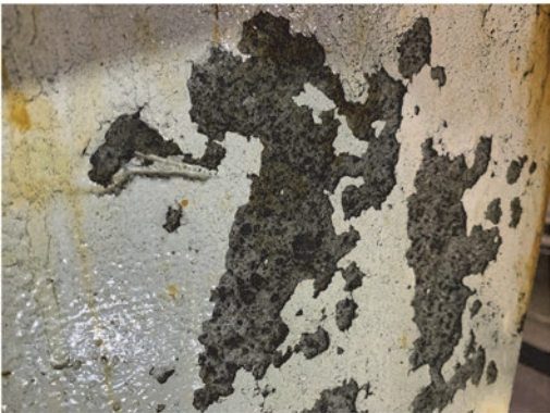
図-1 剥がれが生じたトンネル内の塗装
