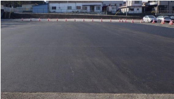
写真 5. 1 試験舗装施工完了
