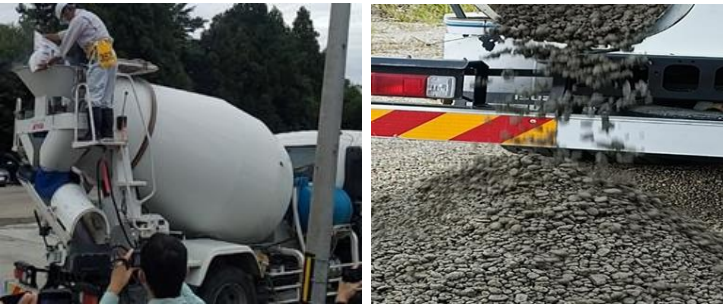
写真－1 粒状化再生骨材製造状況
