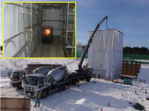
写真-1 寒中施工の様子
