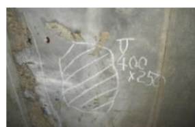
写真1 うきの損傷
