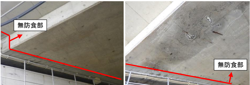
適用 1 年経過後 適用 10 年経過後 写真 1 外観観察（電気防食適用範囲外）結果の一例
