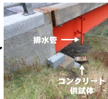
写真-1 暴露実験の様子
